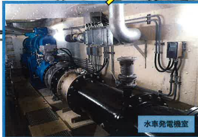
水車発電機室
